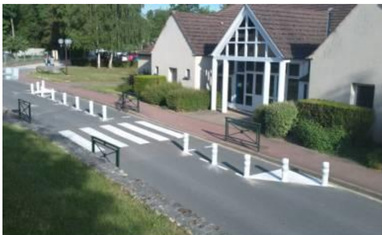
Réalisation (19/06/11) rue du Port
